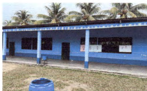
Foto 2: VISTA EXTERIOR DEL MODULO DE AULAS.
