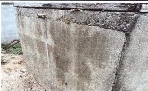
Foto 11: MUROS Y PISO DE SANITARIOS INCOMPLETOS.
