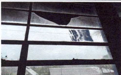
Foto 5: VENTANAS EXISTENTES, DETERIORADAS Y QUEBRADAS.
