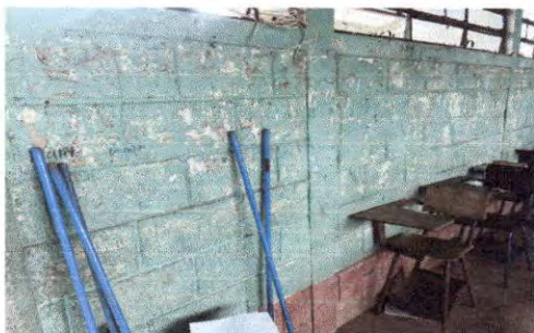
Foto 3: LOS MUROS INTERIORES QUE SI CUENTAN CON PINTURA NO CUENTAN CON NINGUN MANTENIMIENTO.
