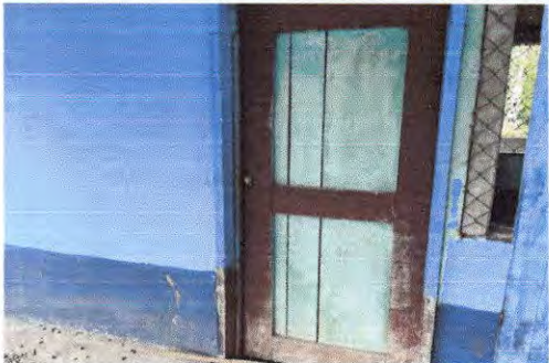
Foto 7: PUERTAS DE MADERA DE AULAS DETERIORADAS Y SIN CHAPAS.
