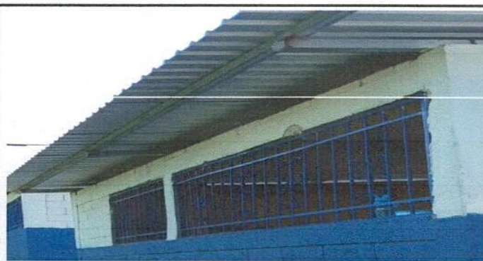
Foto 5: Sustitución de balcones de madera por metal
