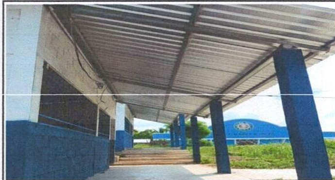
Foto 2: Sustitución de estructura de madera por metal
