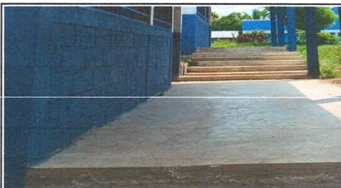
Foto 3: Sustitución de piso de torta de concreto
