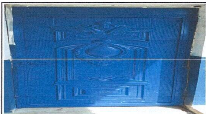
Foto 4: Sustitución de puerta
