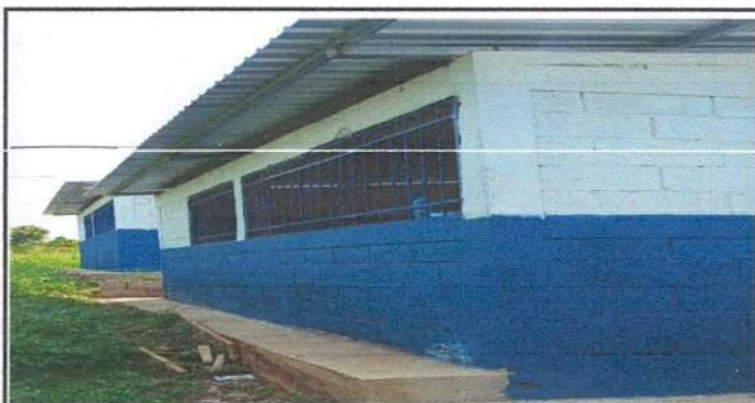
Foto 6: Pintura en muros exteriores e interiores
