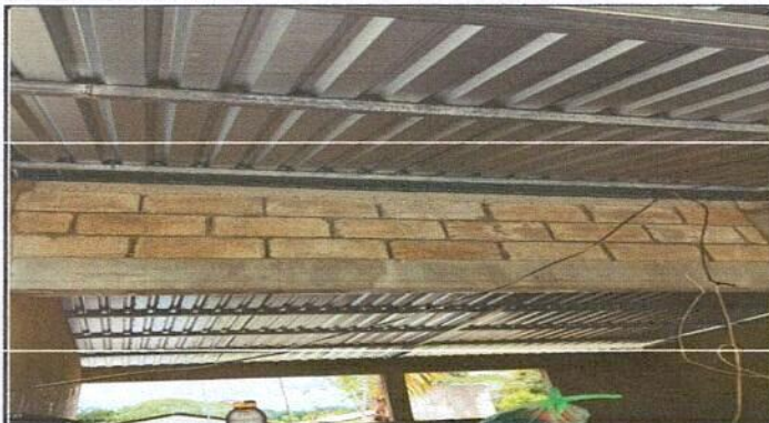
Foto 2: Sustitución de estructura de madera por metal
