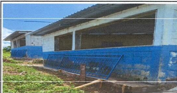
Foto 5: Sustitución de balcones de madera por metal
