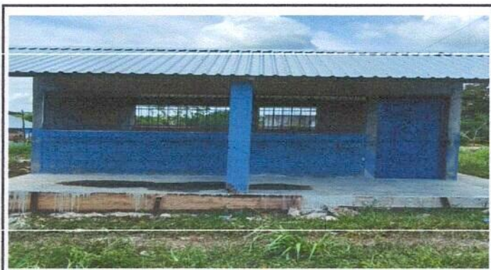
Foto 4: Sustitución de puerta
