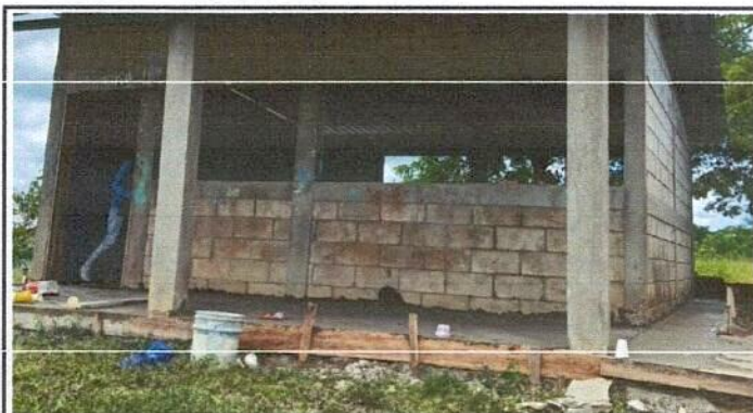
Foto 3: Sustitución de piso de torta de concreto
