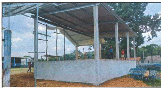
Foto 5: Sustruicio de piso de torta de concreto...
