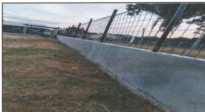
Foto 3: Repello en muro.
