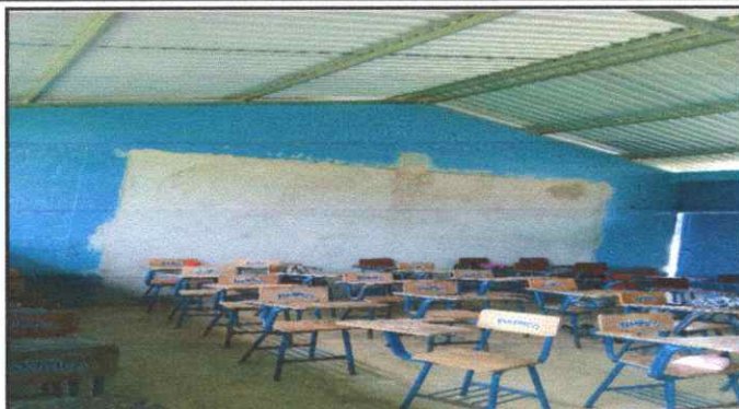
FOTO 2: Reparacion de Pared.
