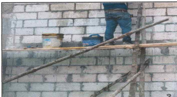
Foto 3: Reparacion de Pared...
