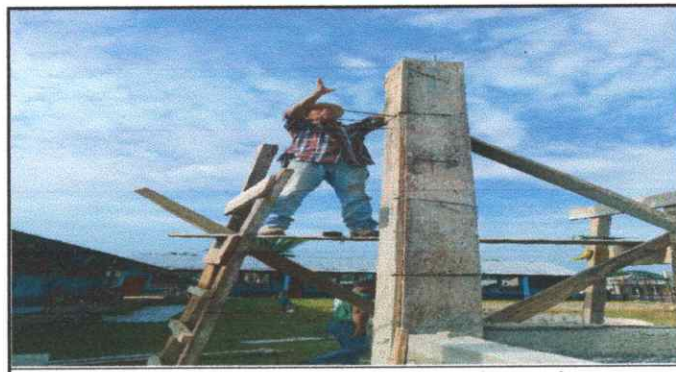
Foto 6: Sustitucion de horcones de maderas por columnas de concretos...
