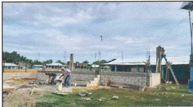
Foto 4: Sustitucion de estructura de madera...
