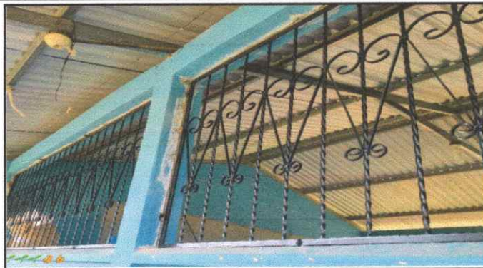
Foto 2: Sustitucion de Balcones de las primeras ventanas...
