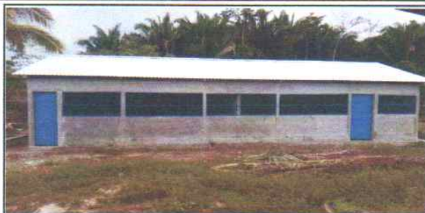
Foto1: Vista instalada de balcones en módulo 3
