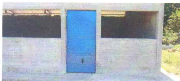
Foto 4: Vista de puerta instalada en una de las aulas.
