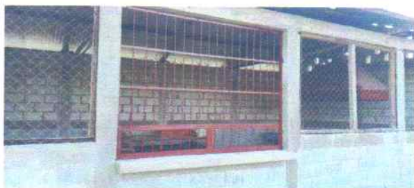
Foto 3: Vista instalada de balcón en la cocina.
