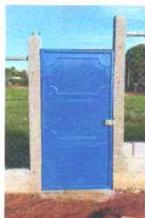
Foto 1: Vista de puerta instalada hacia salida de campo de futbol.
