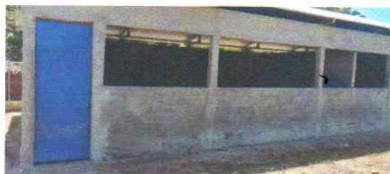
Foto 5: Vista de repello en paredes
