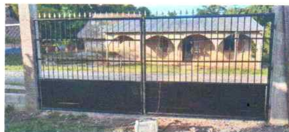
Foto 2: Vista de Portón instalada en la parte interior del predio.
