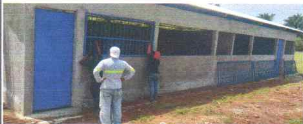
Foto1: Vista de la instalación de 18.5 m2 de balcones
