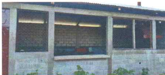
Foto 2: Vista externa de la ventana grande de la cocina.
