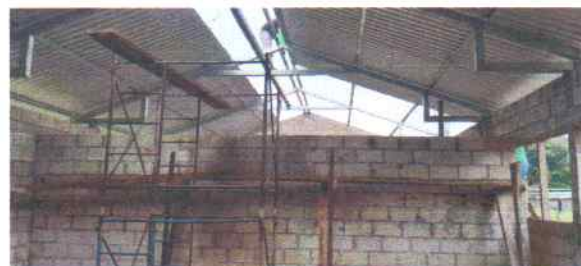
Foto 6: Vista de la instalación de costaneras y techado.
