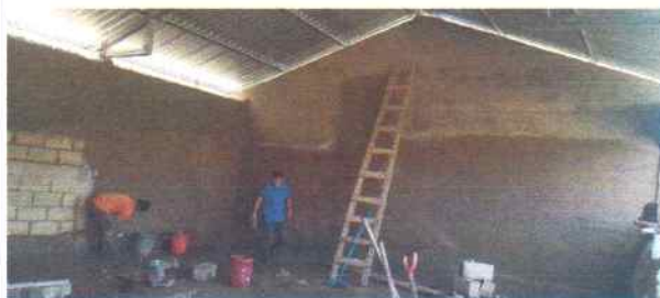
Foto 3: Vista previa del repello en una de las aulas.
