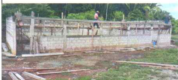
Foto 1: Vista general del establecimiento en construcción.
