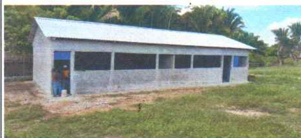
Foto 4: Vista previa de la instalación de las puertas de las aulas.
