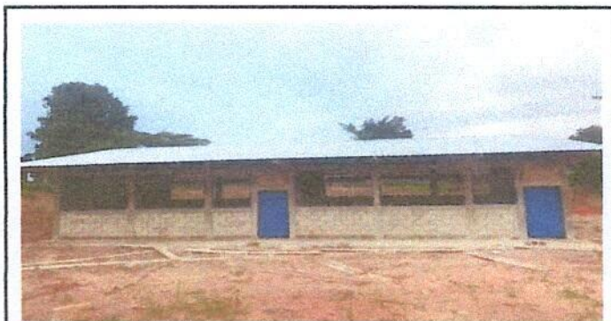
Foto 6: Se sustituyo las paredes de madera por block.
