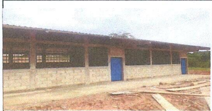
Foto 4: Se sustituyo puertas de madera por metal.
