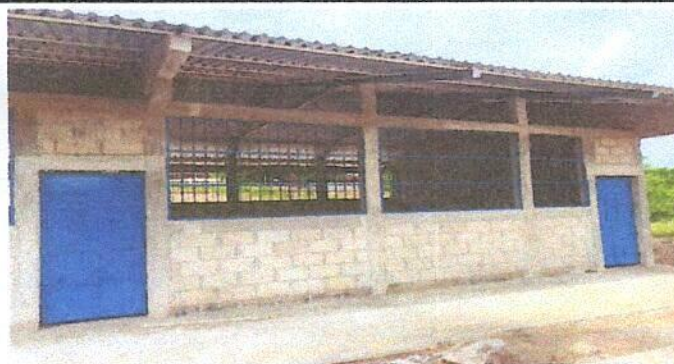
Foto 3: Se sustituyo la estructura de madera por el de metal.
