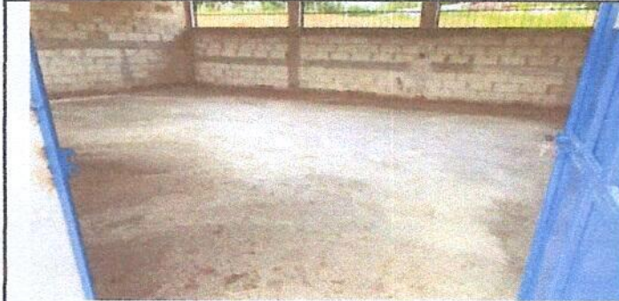
Foto7: Sustrucción de piso de torta de cemento.
