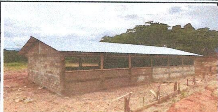
Foto 2: Sustitución de Capote nuevo.
