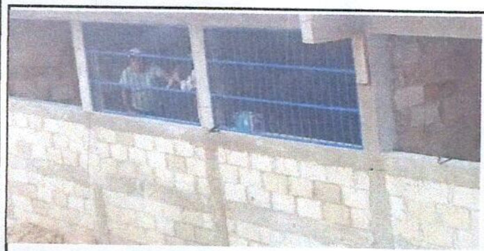
Foto 5: Instalación de balcones.
