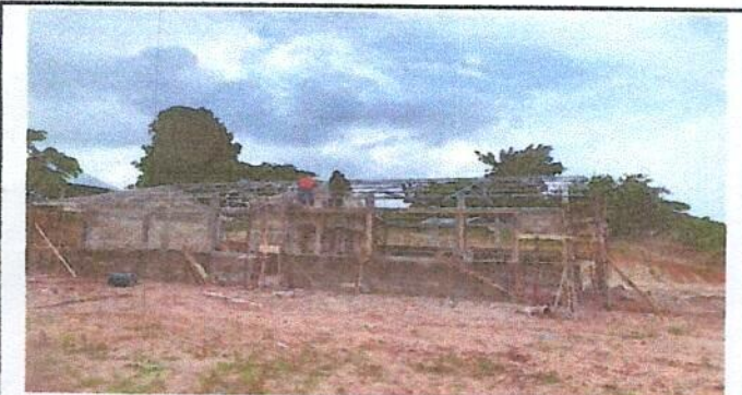
Foto 3: Se esta sustituyendo la estrucra de madera por metal.
