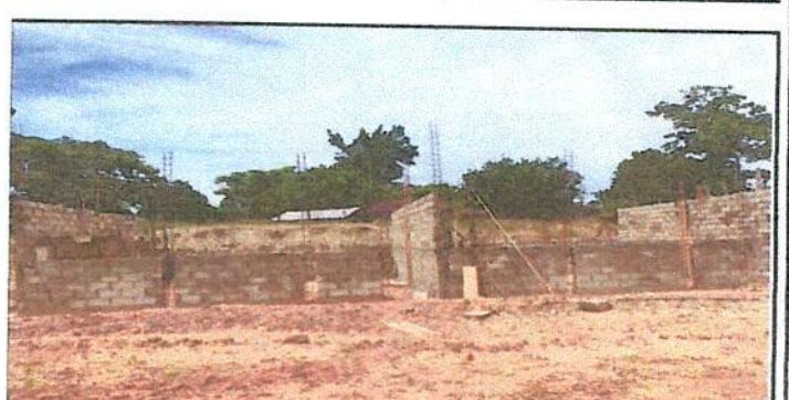
Foto 6: Sustitución de paredes de madera por block.
