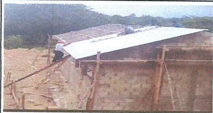
Foto1: .Sustitución de lámina por lámina troquelada.
