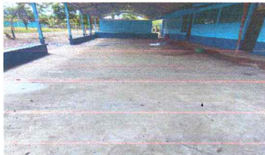
Foto 2: sustitucion de torta de cemento.
