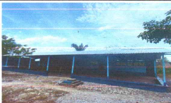
Foto 6: sustitucion de láminas.
