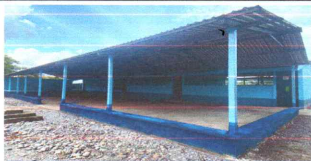
Foto 5: sustitucion de horcones.
