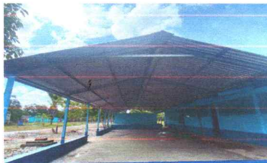
Foto 4: sustitucion de costaneras
