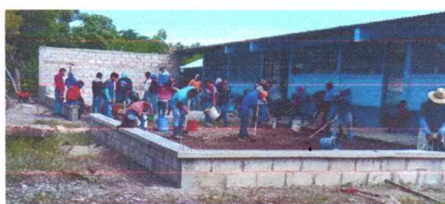
Foto 2: sustitucion de torta de cemento.
