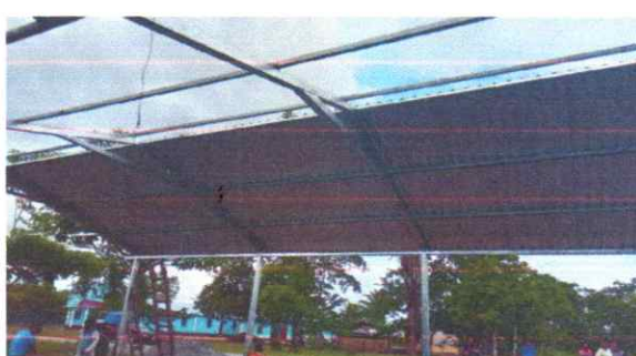
Foto 4: sustitucion de costaneras
