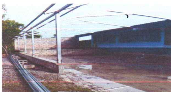
Foto 5: sustitucion de horcones.
