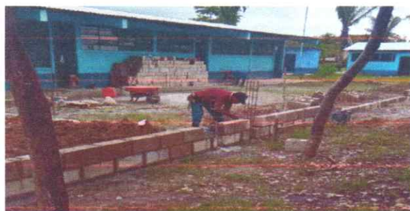
Foto 3: sustitucion de block.
