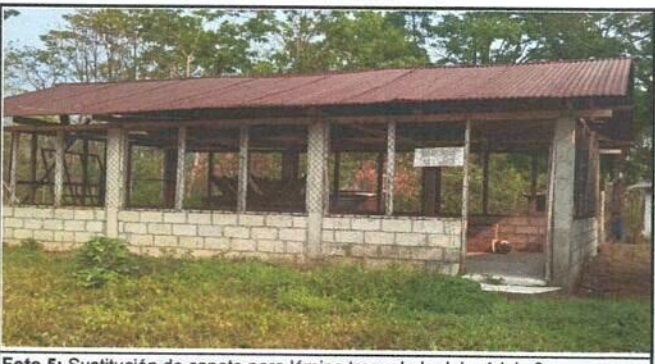
Foto 5: Sustrucción de capote para lámina troquelada del módulo 2.
