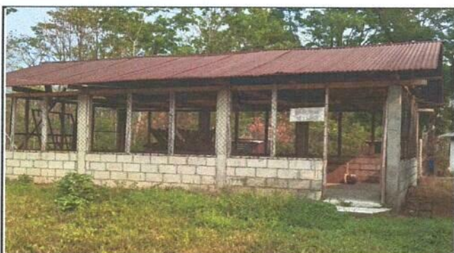
Foto 4: Sustrucción de la cubierta de lámina por lámina troquelada del módulo 2.
