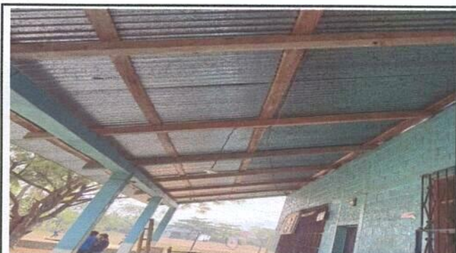
Foto 3: Sustrucción de la estructura de madera por metal del módulo 1.
