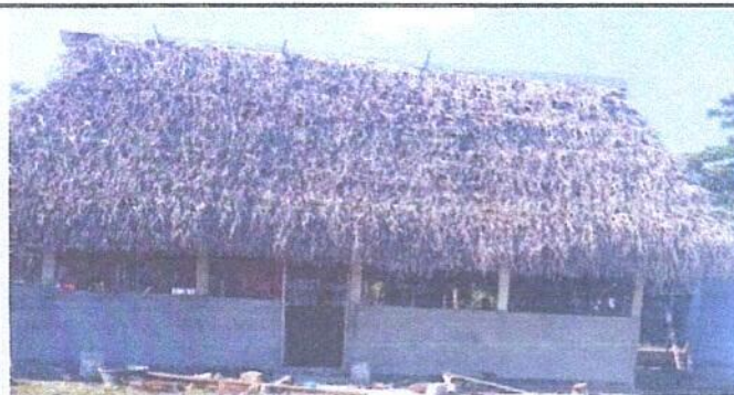
Foto 4: VISTA DE COCINA REPARADA EN PARTE EXTERNA
