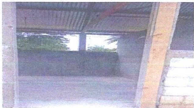
Foto 1: SUSTITUCION DE PUERTAS
