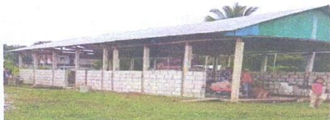
Foto 3: REPARANDO PAREDES Y COLUMNAS
