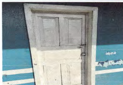
Foto 4: PUERTAS DE MADERA DE AULAS, SIN MANTENIMIENTO PICADAS Y CON CHAPAS CAIDAS.
