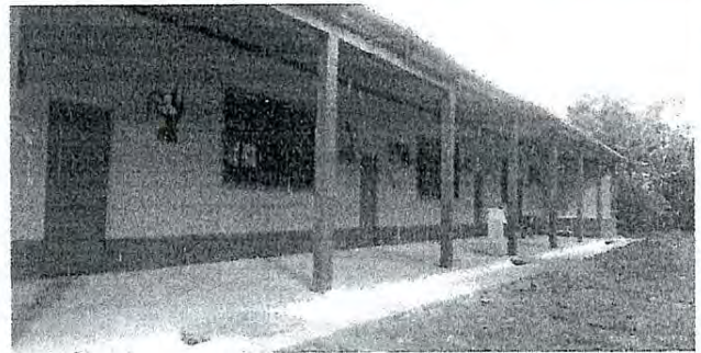
Foto 4: vista de la escuela pintada completamente y sus puertas.
