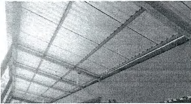
Foto1: ya estan instaladas las estructuras de metal y laminas troqueladas
