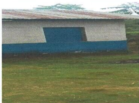
Foto 3: Instalación de ventana de metal para la cocina
