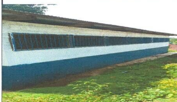
Foto 4: Instalación de baldones de metal para el edificio escolar
