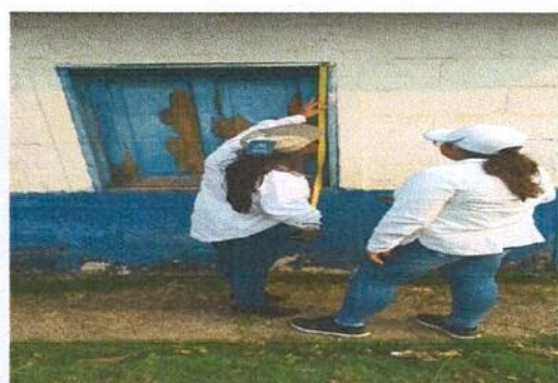
Foto 3: Instalación de ventana de metal para la cocina
