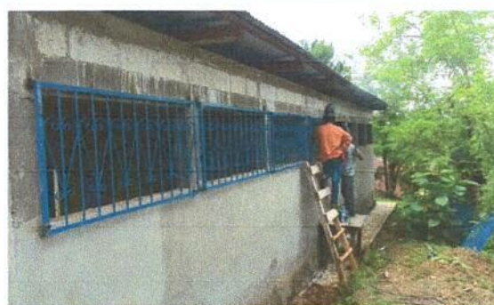
Foto 4: Instalacion de balcones de metal para el edificio escolar
