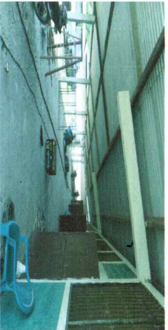
Foto 5: Vista general en proceso de cambio.
