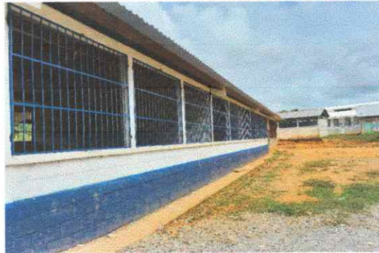
Foto 4: EL ESTABLECIMIENTO EN LA PARTE DE ATRÁS CON SUS BALCONES NUEVOS.
