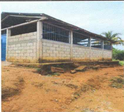
Foto1: FINALIZACION DE BALCONEADO Y PUERTA SUSTITUIDA DEL AULA DE PREPRIMARIA.
