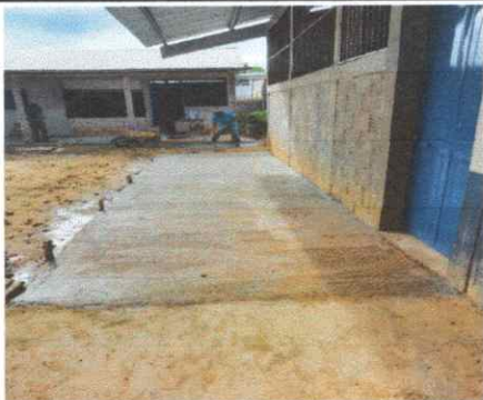
Foto 3: LABOR FINALIZADA DE BANQUETA DEL CORREDOR DE UN AULA.
