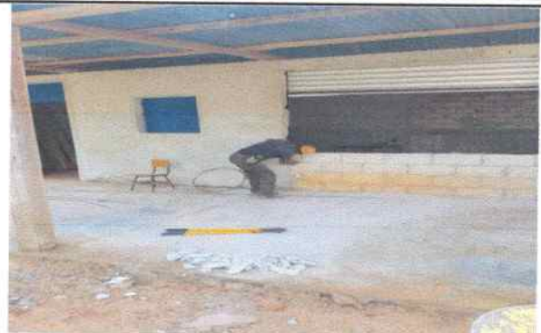
Foto 2: ELABORACION DE PISO Y REPELLO EN EL EXTERIOR DE LA COCINA ESCOLAR.
