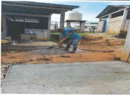
Foto1: PREPARACION DE MATERIAL PARA EL PISO DEL INTERIOR DE LA COCINA ESCOLAR.
