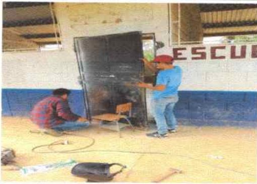
Foto 3: SUSTITUCION DE LAS PUERTAS DEL ESTABLECIMIENTO.
