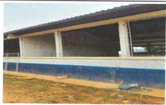
Foto 4: INICIO DE SUSTITUCION DE LOS BALCONES DEL ESTABLECIMIENTO EDUCATIVO.
