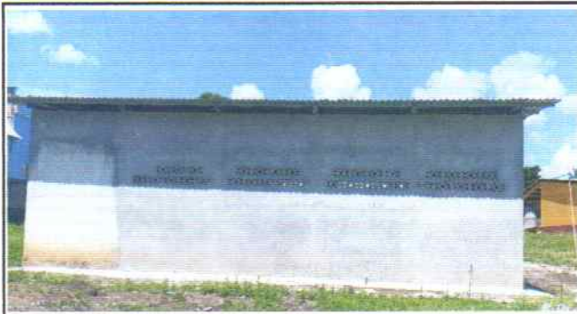
Foto 1: VISTA DE LOS TRABAJOS REALIZADOS EN LA PARTE DE ATRÁS DEL MÓDULO DE PREPRIMARIA
