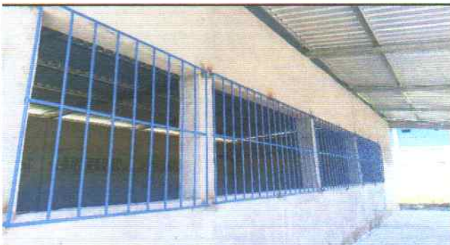
Foto 3: CAMBIO DE BALCONES EN EL MÓDULO DE PREPRIMARIA
