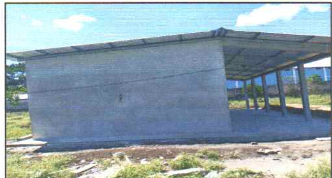
Foto 4: PAREDES REPELLADAS EN EL MÓDULO DE PREPRIMARIA
