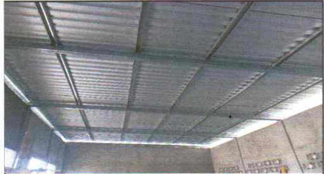
Foto 2: ESTRUCTURA DE SOPORTE DE METAL EN EL TECHO DEL MÓDULO DE PREPRIMARIA
