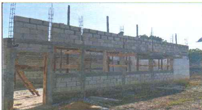
Foto 3: TALLADO DE VENTANALES PARAQUE POSTERIORMENTE SE REALICE LA INSTALACION DE BALCONES EN EL MÓDULO DE PREPRIMARIA
