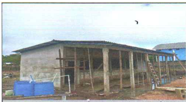
Foto 5: PROCESO DE INSTALACIÓN DE CORREDOR EN EL MÓDULO DE PREPRIMARIA.
