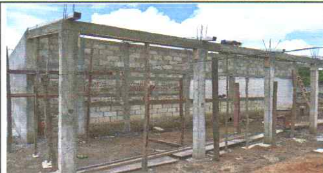
Foto 2: TRABAJOS DE INSTALACIÓN DE SOPORTE DE METAL Y LÁMINA TROQUELADA ALUCINK CALIBRE 26 EN MÓDULO DE PREPRIMARIA
