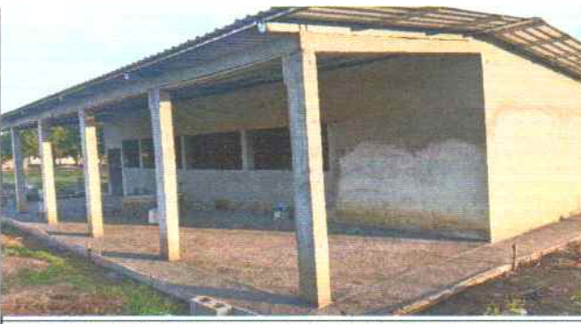
Foto 6: VISTA DEL CORREDOR CON PISO DE TORTA DE CONCRETO EN EL MÓDULO DE PREPRIMARIA
