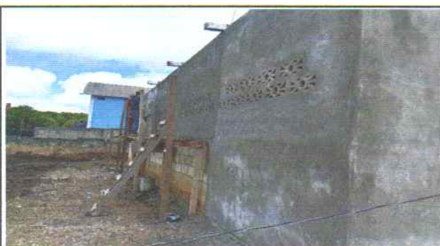
Foto 4: PROCESO DE REPELLO EN PAREDES DEL MÓDULO DE PREPRIMARIA.
