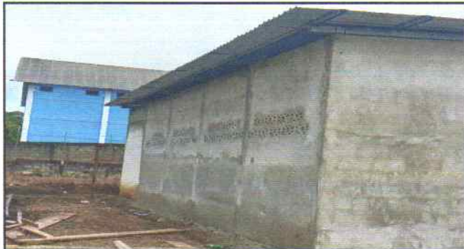
Foto 1: VISTA DE LA LÁMINA EN PROCESO DE INSTALACIÓN EN EL TECHO DEL MÓDULO DE PREPRIMARIA
