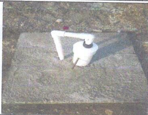
Foto 1: POZO. EL TRABAJO DE MEJORAMIENTO HA FINALIZADO EXITOSAMENTE.
