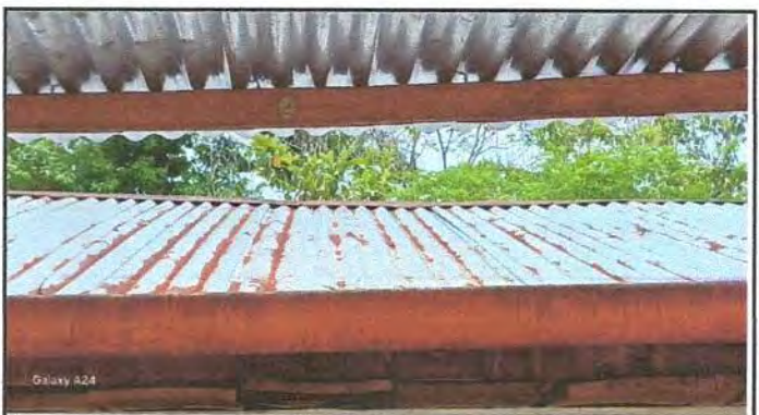
Foto 4: MODULO DE AULA Sustitución de techo de lamina por lámina troquelada aluzinc calibre 26.
