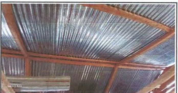
Foto 6: MODULO DE AULA Sustitución de soporte de madera por metal.
