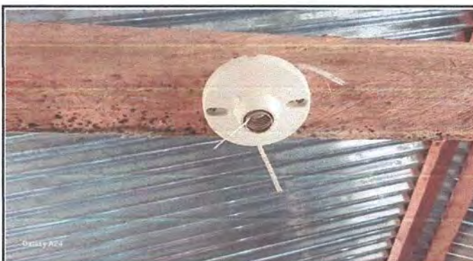
Foto 4: MODULO DE COCINA Sustitución de plafonera.
