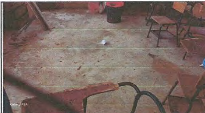
Foto 2: MODULO DE COCINA Sustitución de azulejo.
