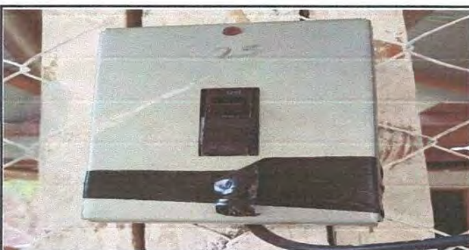
Foto 5: MODULO DE COCINA Sustitución de flípones.
