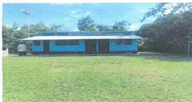
Foto1: Sustitución de cubierta de lamina por lamina troquelada
