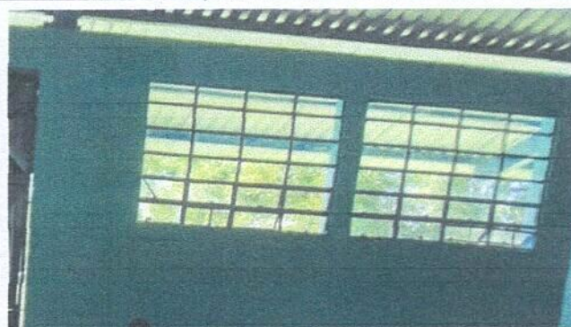
Foto 2: Sustitución de vidrios de ventanas
