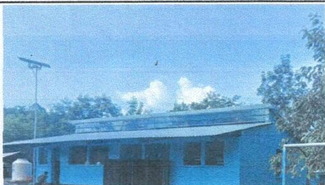
Foto 3: sustitucion de capote de lamina para lamina troquelada
