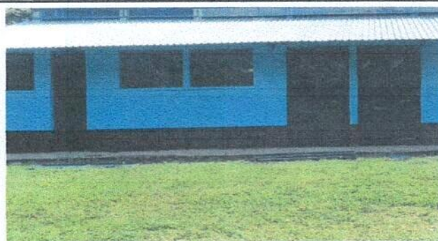
Foto 4: sustitucion de puertas de metal por puertas de metal.
