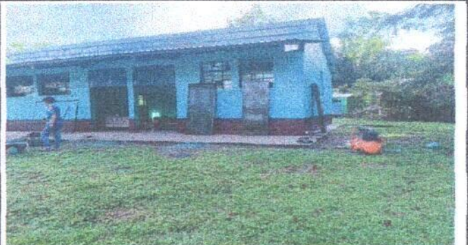
Foto 4: sustitucion de puertas de metal por puertas de metal.
