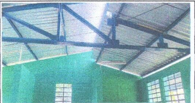
Foto 6: mantenimiento de estructura soporte de metal
