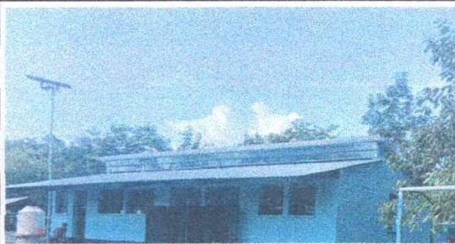
Foto 3: Sustitución de capote de lamina troquelada
