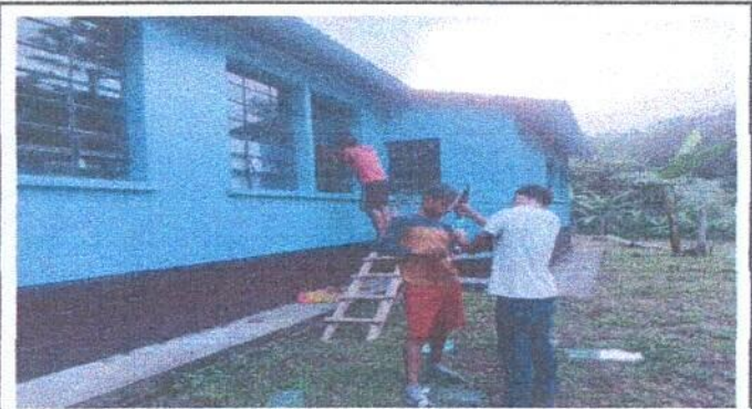
Foto 2: Sustitución de vidrios de ventana
