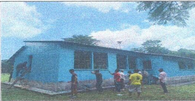
Foto 5: pintura en muro exteriores e interiores del centro Educativo
