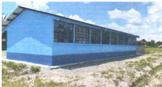
Foto1: Pintura exterior del modulo 1
