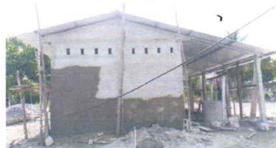
Foto 5: Repello en paredes de la cocina escolar
