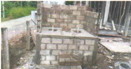
Foto 3: Sustitucion de paredes en servicios sanitarios
