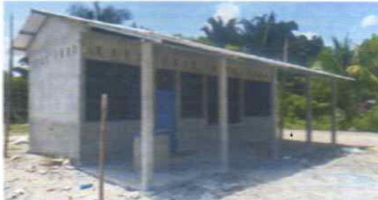
Foto 2: Sustitucion de estructura de madera por metal
