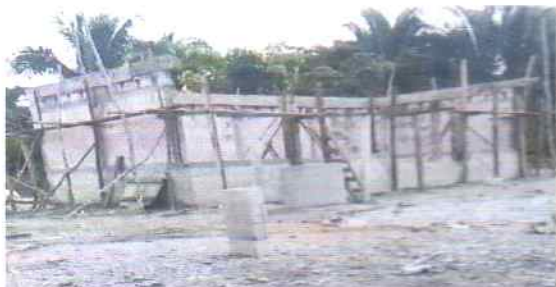
Foto1: Sustitucion de pared de madera por block
