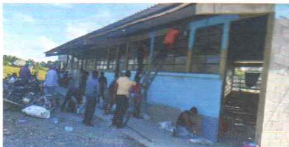
Foto 4: Pintura exterior de paredes en el modulo 1
