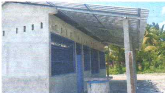
Foto 6: Sustitucion de balcones de cocina escolar
