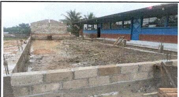
Foto 3: Reemplazamiento de bigas y estructura de madera, por base metálica y concreto.
