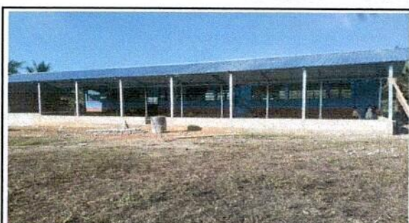
Foto 6: Estructura casi completa para fase final.
