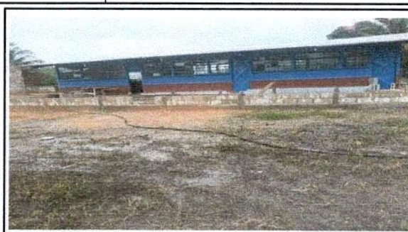
Foto 2: Base para la nueva ampliación para el corredor.
