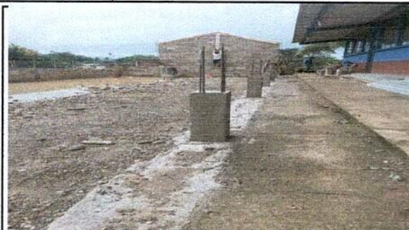
Foto 1: Vista del frente de la escuela donde se está interviniendo la infraestructura del corredor.
