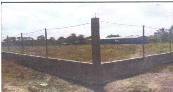
Foto 3: Reparacion de Cerco perimetral sustituido.
