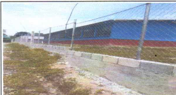
Foto 2: sustitucion de Maya dañada del perímetro del centro educativo finalizado.
