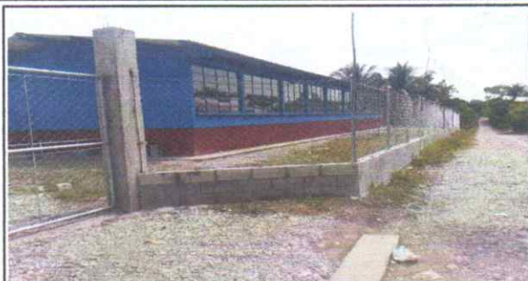
Foto 1: Vista general del establecimiento y entrada de los alumnos en el lado oriente reparado.
