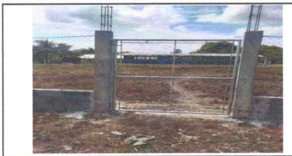
Foto 6: Portón lateral sustituido
