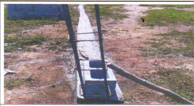
Foto 5: sustitucion dela base principal de la malla en malas condiciones.
