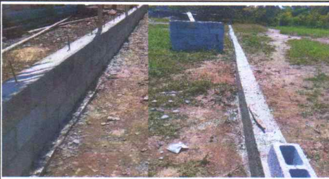
Foto 3: sustitucion del Cerco perimetral que estaba en muy mal estado.
