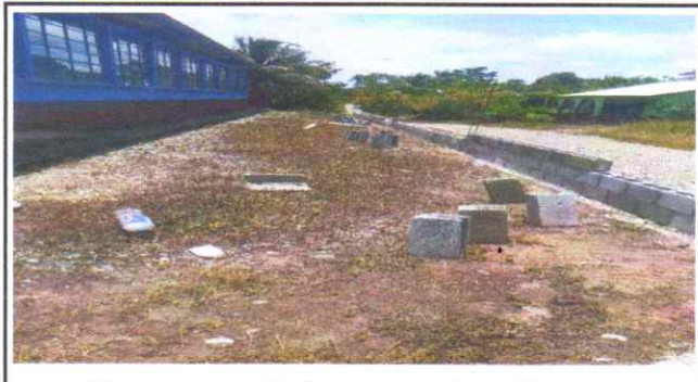
Foto 2: sustitucion de la base de la Maya dañada del perimetro del centro educativo.
