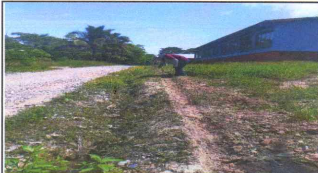
Foto 4: Inicio de sustitucion de la base de concreto del muro perimetral.
