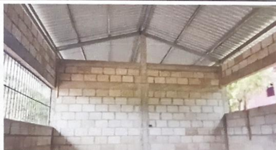
Foto 6: Finalización de estructura metálica
