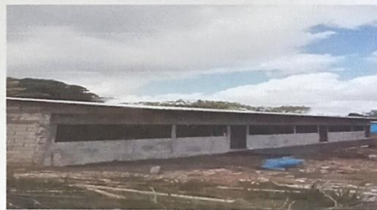
Foto 4: Reparación de pared del establecimiento
