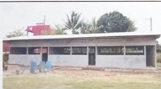
Foto 5: Finalización de entechado del establecimiento
