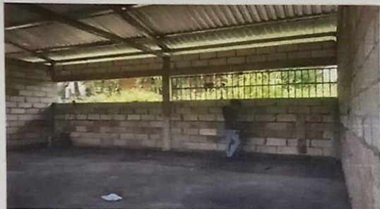
Foto1: Reparación de piso del establecimiento
