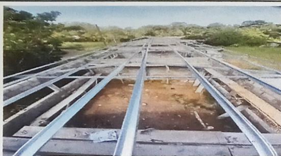
Foto 3: Colocacion de estructura de metal del establecimiento
