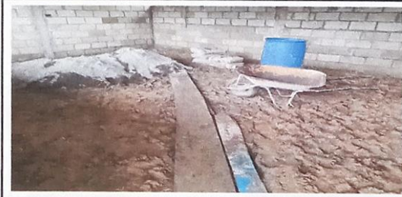
Foto 6: Reparacion de torta de cemento
