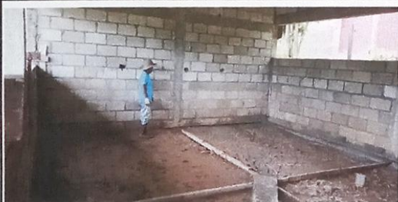
Foto 5: Reparacion de torta de cemento del establecimiento
