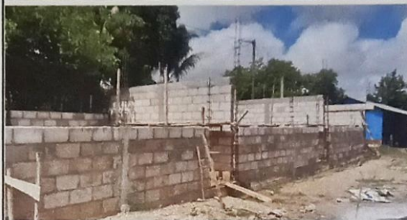
Foto 2: Reparacion de pared del establecimiento
