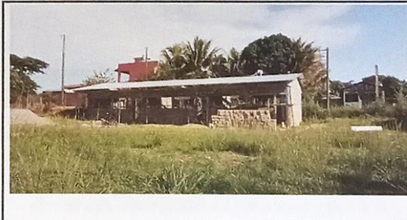
Foto 4: Colocacion de laminas troqueladas del establecimiento
