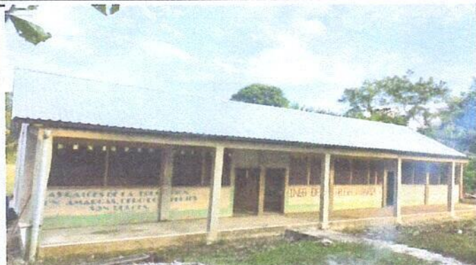
Foto 1: Vista general del establecimiento con la estructura metálica lámina troquelada
