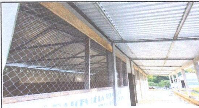
Foto 2: Culminación total del entechado de corredor
