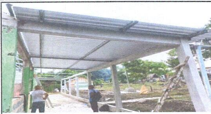
Foto 2: Entechado de corredor con las nuevas láminas troqueladas
