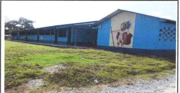
Foto 4: Finalizacion de pintura en muro exteriores e interiores
