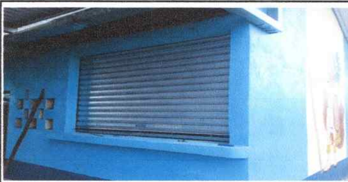
Foto 5: Finalizacion de cortinas
