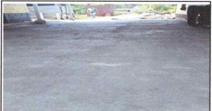
Foto 2: finalización de construcción de torta de cemento
