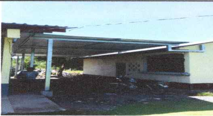
Foto 1: finalización de vaces metalicas, fabricaciones de estructuras metalicas y finalizacion de la laminas troqueladas.
