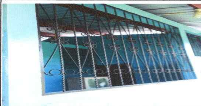
Foto 3: Finalizaciones de mantenimiento y pintada de balcones metalicos
