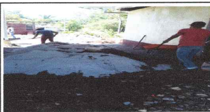
Foto 5: Construccion de torta de cemento
