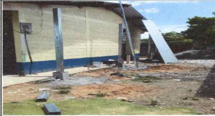
Foto 2: construccion de cimientos de concreto y metalicos instalados
