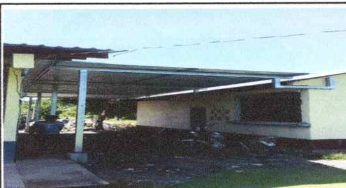
Foto 3:frabricacion de estructura metalicas y instalacion de laminas troquelada
