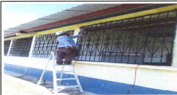
Foto 4: Mantenimiento de valcones y pintadas
