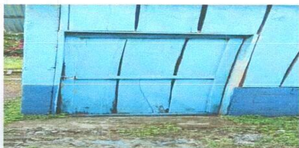
Foto 5: sustitucion de puerta.
