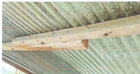
Foto 2: sustitucion de lamina
