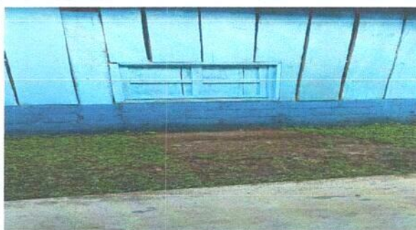
Foto 4: sustitucion de ventana.
