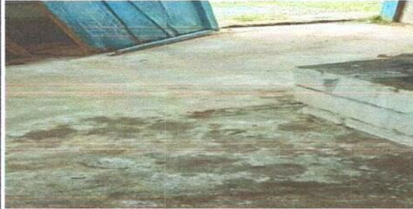
Foto 2: reparacion de torta de concreto
