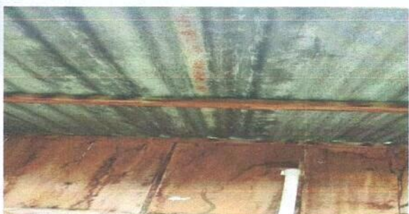
Foto 3: sustitucion de estructura de madera.
