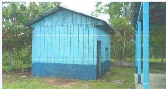
Foto 1: sustitucion de pared e de madera por blok
