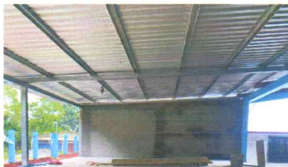
Foto 4: Lamina troquelada calibre 26 y estructura de metal.
