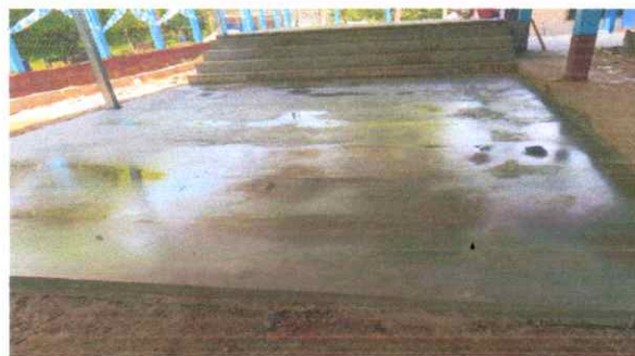
Foto 2: Vista de la torta de piso del centro educativo.
