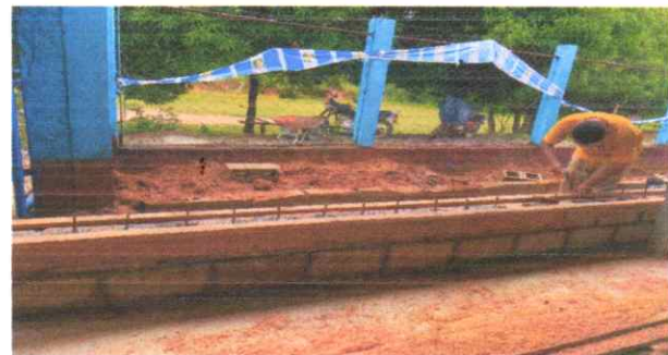
Foto 4: Fundición de soleras horizontales.
