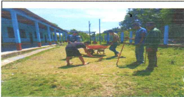
Foto 5: nivelación de terreno para la torta de piso.
