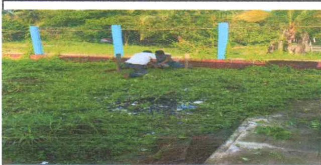
Foto 3: Estructura del patio en malas condiciones
