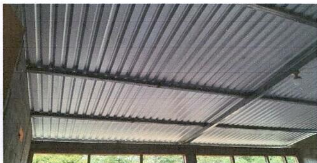
Foto 3: Estructura de metal.
