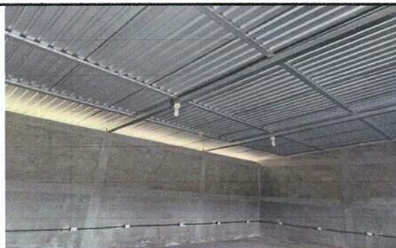
Foto 6: Sistema eléctrico a sustituir.
