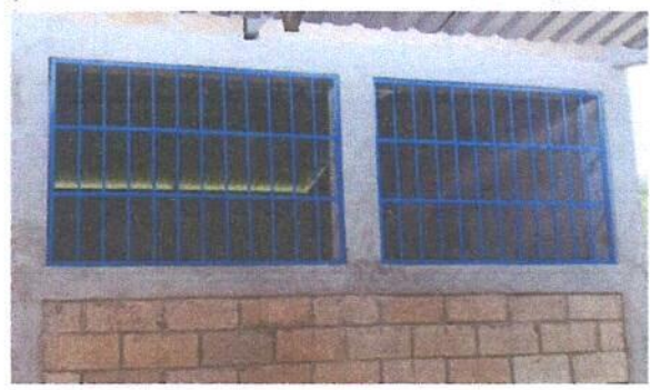
Foto 4: Fotografía reparacion de ventanas de madera por balcones modulo 2
