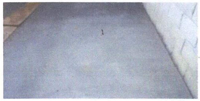
Foto 5: Fotografía interior de piso modulo 2
