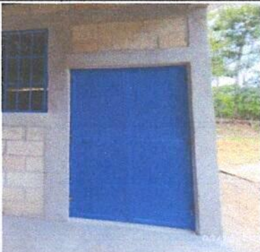
Foto 3: Sustitucion de puerta de madera por puerta de metal modulo 2.
