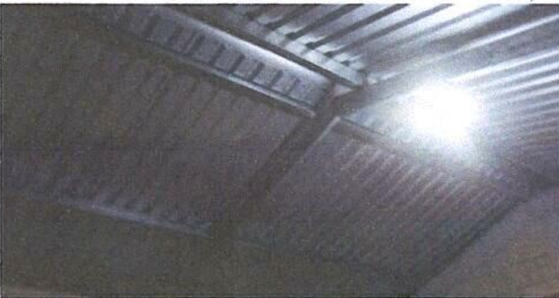
Foto 2: Fotografía sustitucion de techo de madera por metal modulo 2
