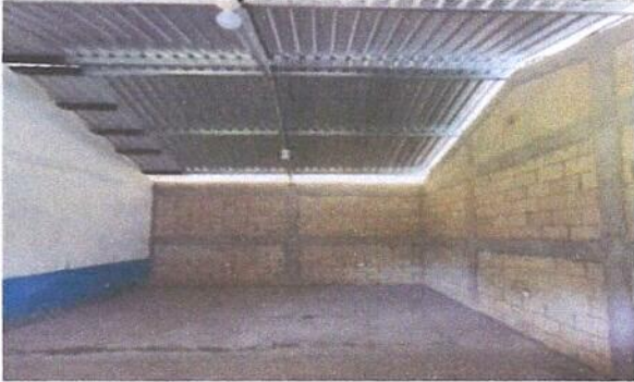
Foto1: Fotografía interior de techo modulo 2
