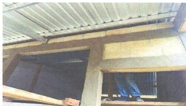
Foto 4: Fotografía de sustitucion de techo modulo 2
