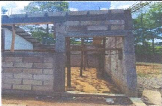
Foto 3: Fotografía reparacion de puerta modulo 2
