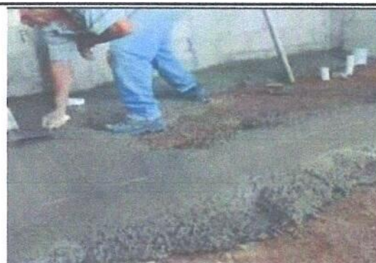
Foto 5: Fotografía de sustitucion de piso de suelo por torta de cemento modulo 2
