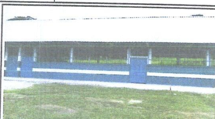
Foto 2: Sustitución de puerta de madera por metal
