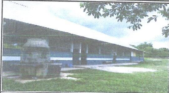
Foto 1: Sustitución de lámina por lámina troquelada
