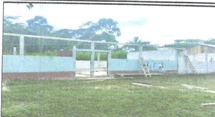
Foto 2: Sustitución de puerta de madera por metal
