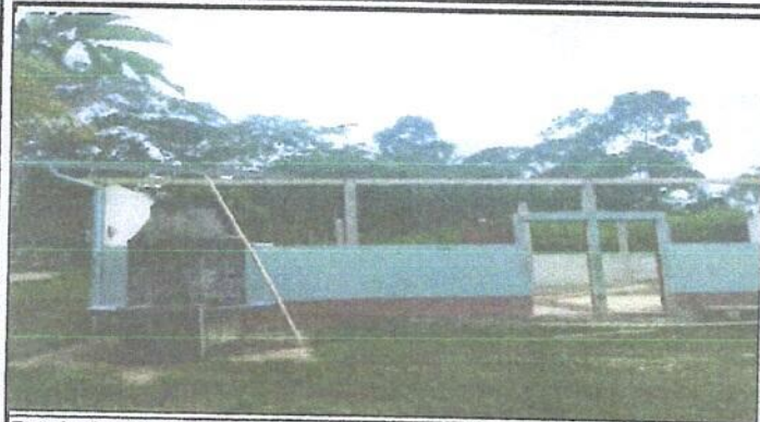
Foto 1: Sustitución de lámina por lámina troquelada
