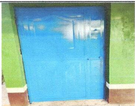
Foto 3: Sustitución de puerta
