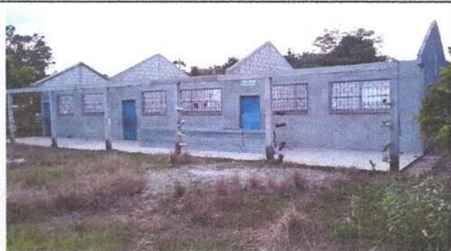
Foto 1: Sustrución de lámina, por lámina troquelada aluzinc calibre 26
