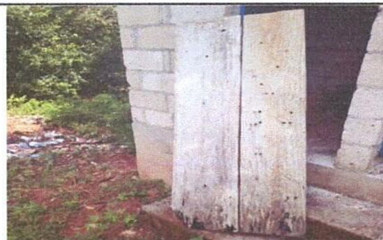
Foto 6: Sustrución de puerta en servicios sanitarios
