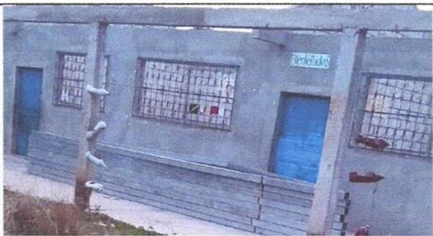
Foto 5: Repello en muro
