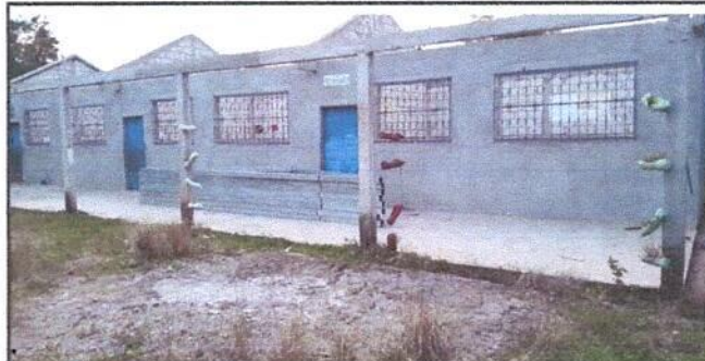
Foto 4: Pintura en muros exteriores e interiores
