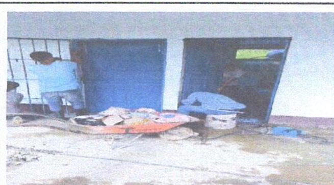
Foto 4: Sustrucción de puerta de madera por metal
