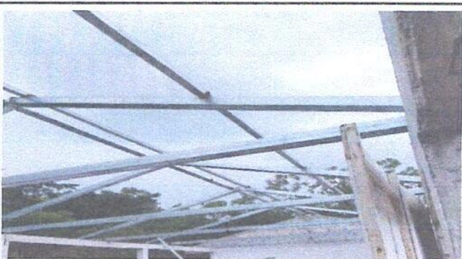
Foto 3: Sustrucción de Estructura de soporte de madera por metal
