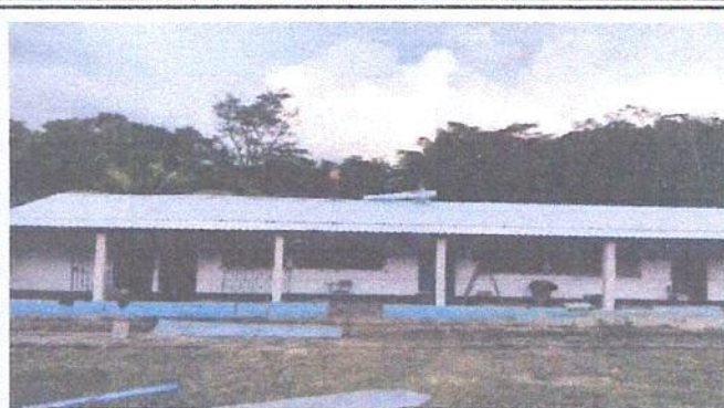
Foto 2: Sustrucción de Capote de lámina, por lámina troquelada
