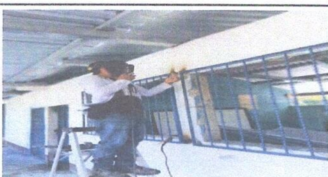
Foto 6: Sustrucción de balcones de metal parte de enfrente
