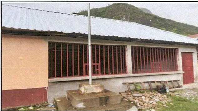
Foto 3: Sustitucion de puerta madera por metal
